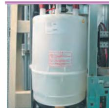
電極式蒸気加湿器は蒸気シリンダーの交換が必要です。
