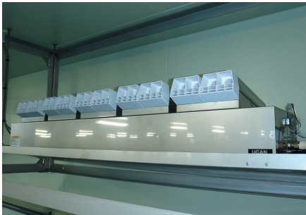
■FT-F205：冷蔵倉庫
